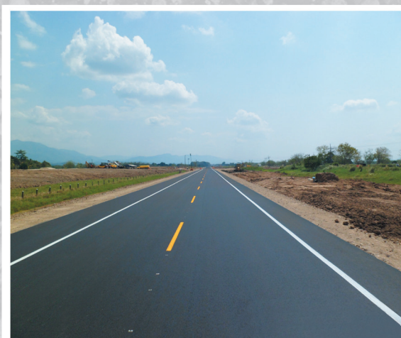
Imagen 2. Concreto Asfáltico construido en Puerto Salgar Cundinamarca, con Asfalto Modificado con Polímero Tipo II, suministrado por IncoAsfaltos®
