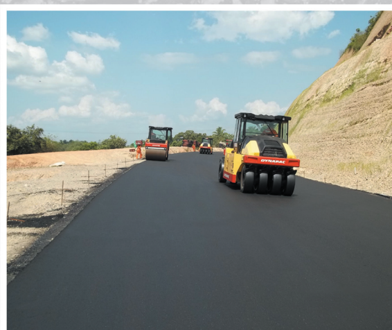
Imagen 2. Concreto Asfáltico construido en Puerto Salgar Cundinamarca, con Asfalto Modificado con Polímero Tipo II, suministrado por IncoAsfaltos®
